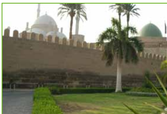
Et eksempel på opstigende fugt.
