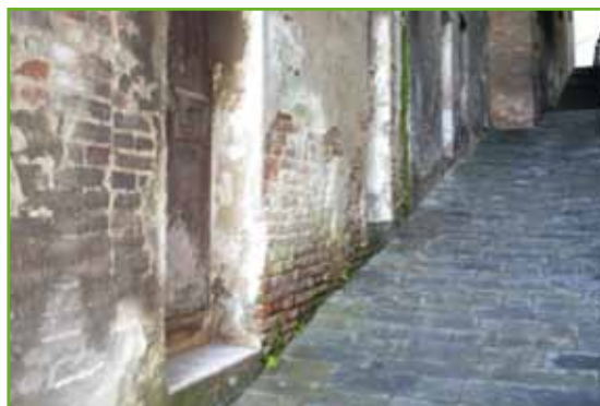
Ødelæggelse af pudset og mørtelfugerne.
